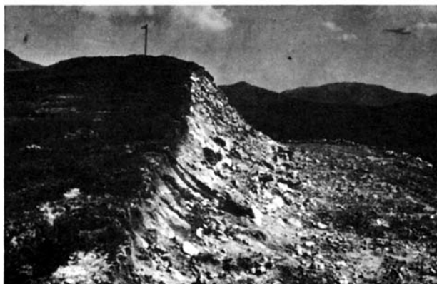
Photo 1. Monument entamé par une route.
